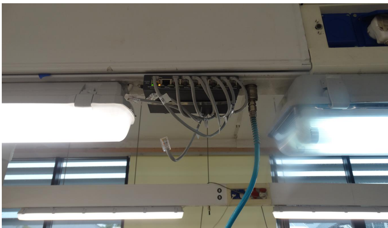
Zdjęcia fragmentu wybudowanej instalacji elektrycznej i teletechnicznej.
